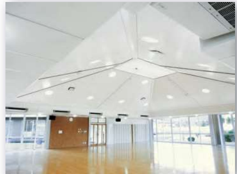
岡山県 津山市立勝北中学校 多目的ホール他
